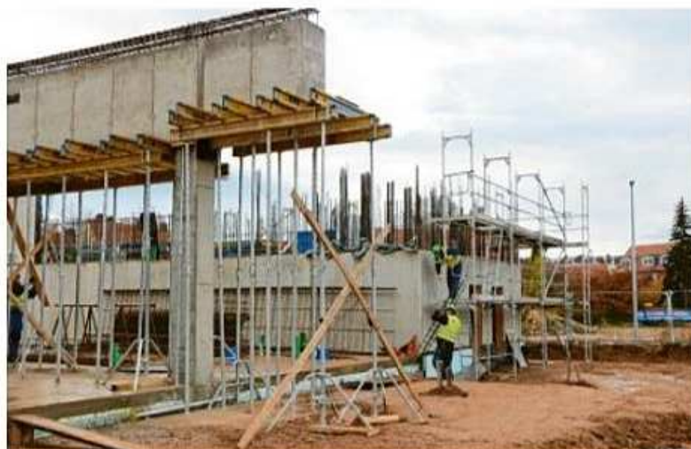
Dort, wo in Zukunft die Lobby des „Ibis Styles“-Hotels sein soll, sind die Arbeiten am Rohbau am weitesten fortgeschritten. Foto: René Lauer
